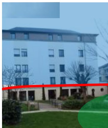
Vue « rue de Dinan » Arrière du bâtiment
